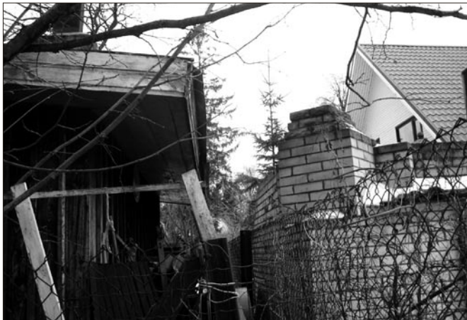
Foto 1 Välikamin on ehitatud nii, et selle korstna ots jääb ~80 cm kaugusele ja paarkümmend sentimeetrit allapoole naaberkrundile varem ehitatud sauna katuseräästast. Kui kamina ehitamisel oleks linnavalitsusega konsulteeritud, ei oleks sellist tuleohtlikku olukorda tekkinud. Tõele au andes kehtis kamina ehitamise ajal selline ES versioon, mis ei nõudnudki linnavalitsuse informeerimist.
